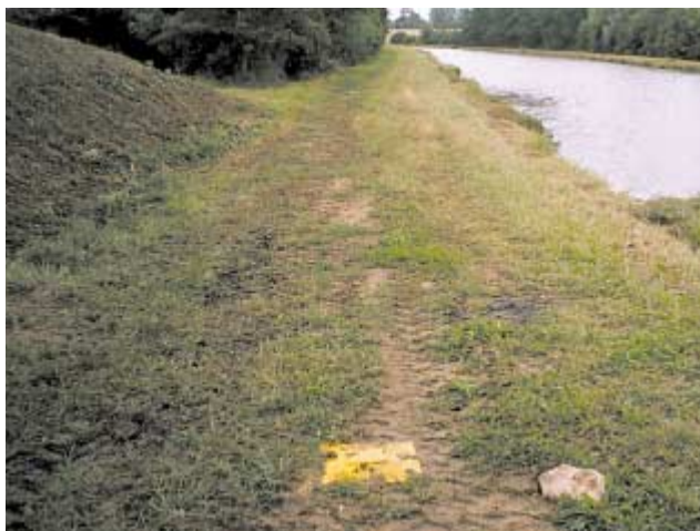
Trappe de visite d'une gaine de fibre optique sur le canal latéral à la Loire
