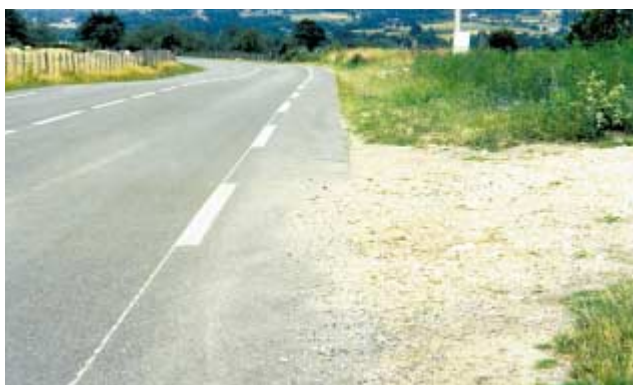
Projection de gravillons sur une bande cyclable
