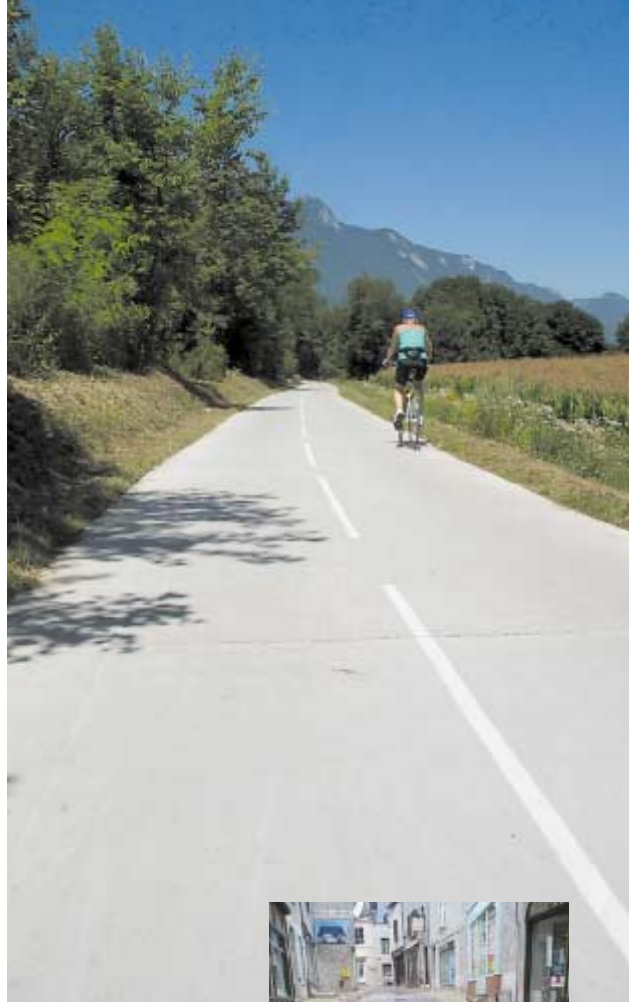
Ci-dessus : voie verte en béton
