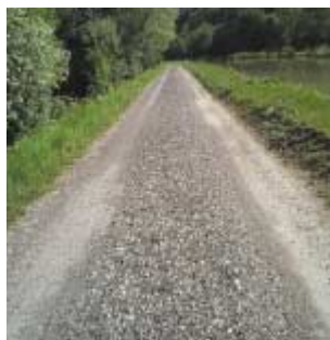
Ci-dessus : chemin de halage en bicouche sur le canal du Centre
