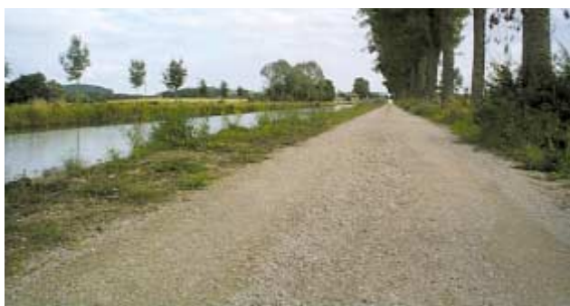
Chemin de halage stabilisé sur le Canal de Bourgogne
