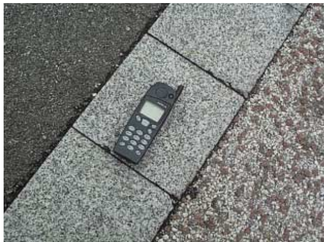
À gauche enrobé classique, à droite enrobé grenailé (avec des gravillons blancs et roses)
