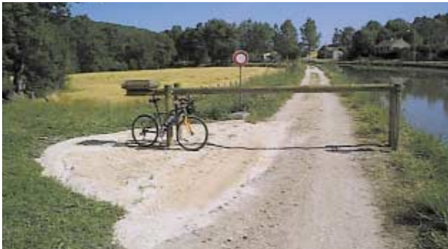
Barrière basculante sur le Canal de Bourgogne, avec passage sur le côté
