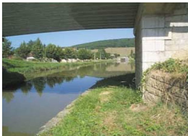
Passage étroit sous un pont : nécessité d'implanter un garde-corp
