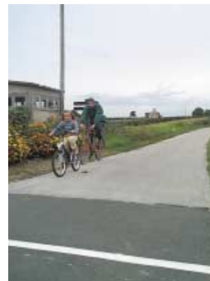
les vélos roulent sur un enrobé déjà patiné, et la reprise plus récente se voit très bien (Voie Verte de Givry à Cluny, réalisée il y a 3 ans)
