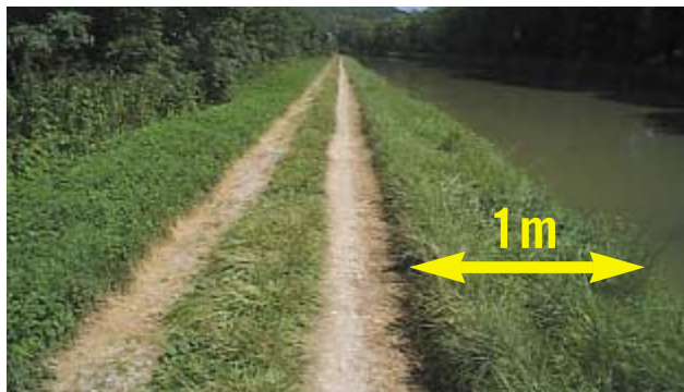
Une berme de 1 m assure la sécurité des usagers
