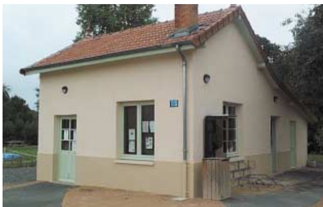
Toilettes intégrées à un bâtiment existant à Saint-Gengoux-le-National, sur la Voie Verte de Givry à Cluny
