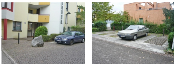
Présence d'enrochement et matérialisation du stationnement
