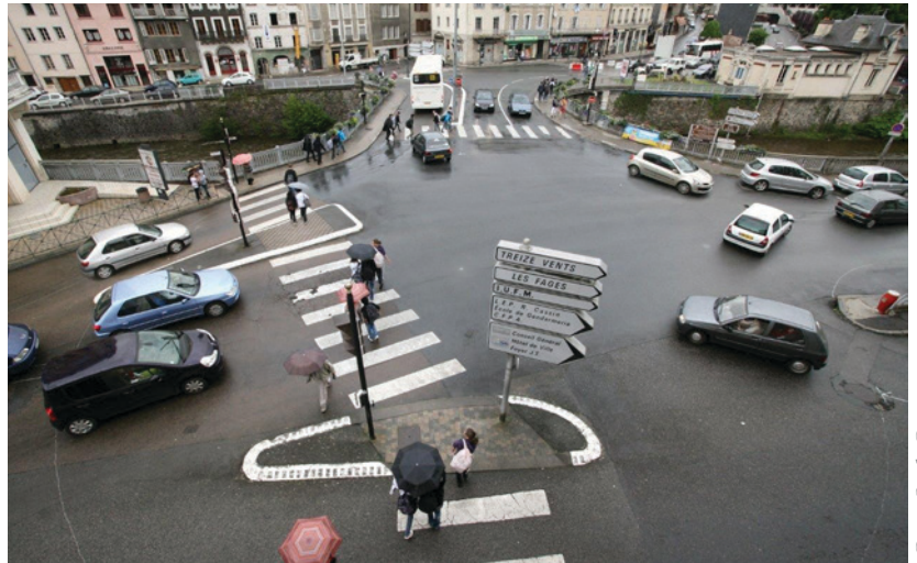
Le pont de la Barrière AVANT aménagement
