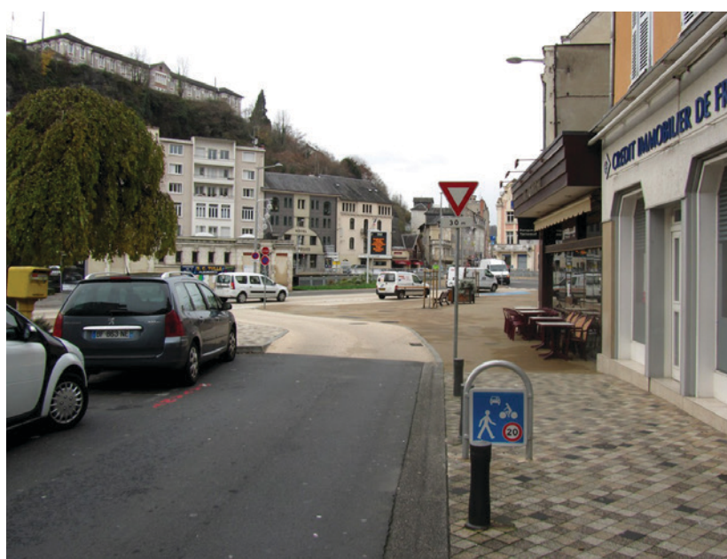
Traitement d'une entrée de la zone de rencontre : surélévation de la chaussée et changement de couleur pour marquer l'entrée.
