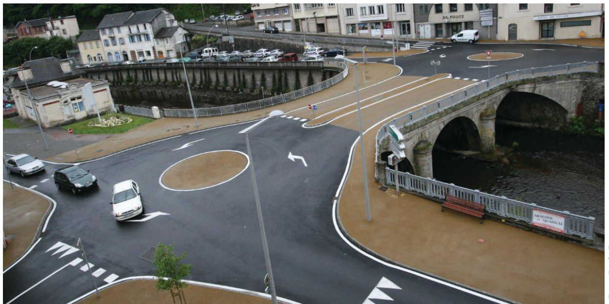
Le pont de la Barrière APRES aménagement
