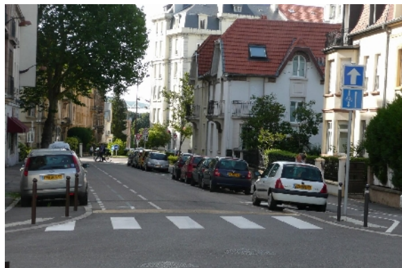
Généralisation du double-sens cyclable dans les rues à sens unique des zones 30. Selon la configuration, ils sont simplement signalés par les panneaux réglementaires ou matérialisés par un marquage de bandes ou d'ilots et de logos vélos.
