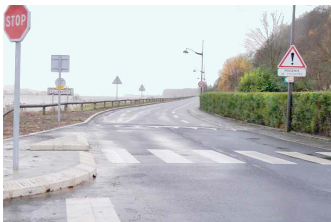
Aménagement d'une entrée de CVCB par surélévation de la chaussée.
