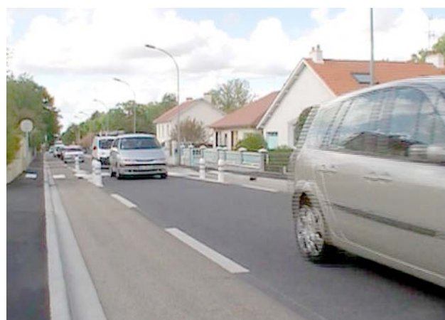
Traitement de la rive par enrobés grenailés
