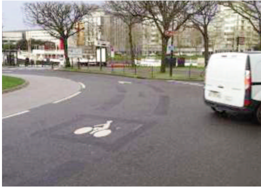
Nantes, marquage du giratoire à l'axe de l'anneau
